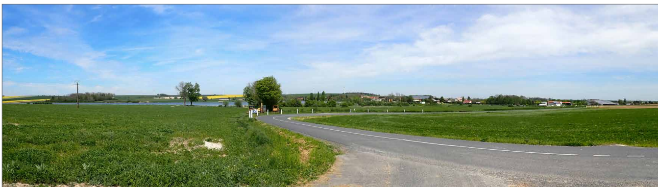
Photo 107 : Visibilité des installations EnR en entrée de bourg, parc éolien visible en arrière-plan et panneaux photovoltaïques sur toiture à droite
