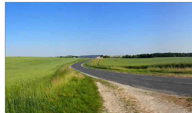
Photo 46 : Le photovoltaïque se développe au sein des structures agricoles, les panneaux équipent de nombreux bâtiments
