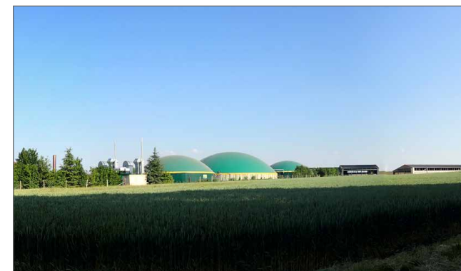
Photo 51 : Méthanisation associée à une structure agricole, située en sortie de bourg (Auve)
