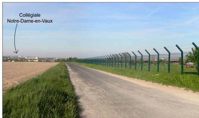
Photo 45 : Une centrale photovoltaïque a investi un ancien terrain militaire à l'Est de Châlons-en-Champagne
