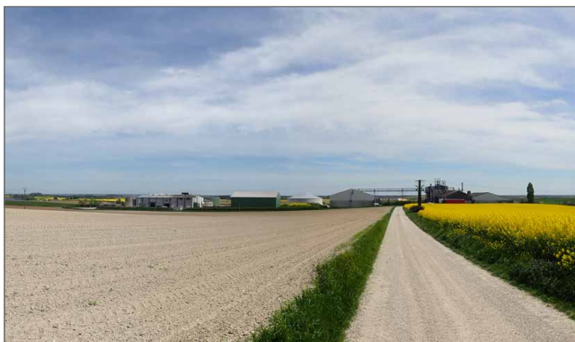
Photo 104 : Envergure de l'unité de méthanisation Champargonne Biogaz
