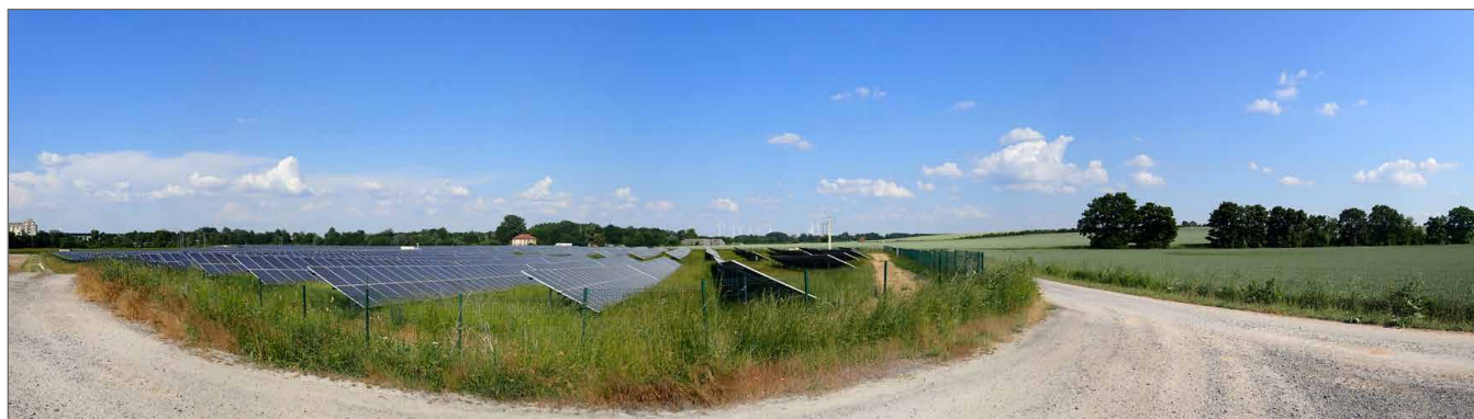
Photo 49 : C'est sur l'ancien terrain d'une distillerie, en sortie du bourg de Betheniville, qu'une centrale photovoltaïque s'est installée ; elle se tient à distance du bourg grâce à la bande de végétation qui longe la Suippe
