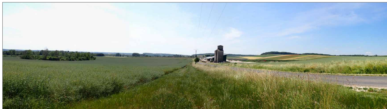
Photo 95 : Le marais s'étend dans le paysage avec un relief relativement doux, les équipements agricoles s'érigent dans la perspective ; des panneaux photovoltaïques sont installés sur le bâti
