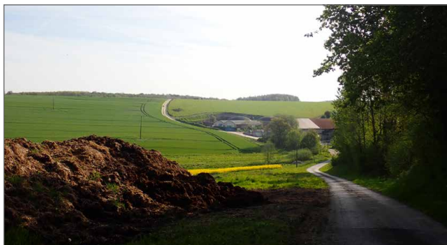
Photo 127 : Site de méthanisation lové dans un creux du relief
