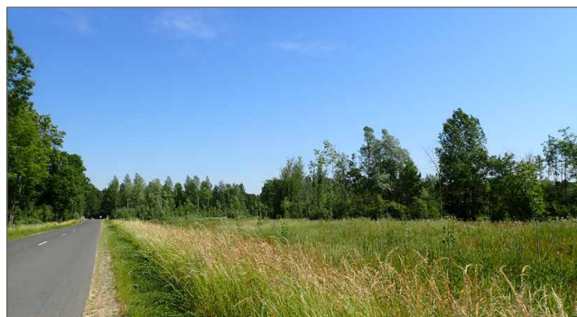
Photo 111 : Au Nord du canal, les espaces sont davantage plantés, espaces rectilignes
